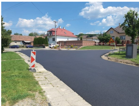
Nový asfaltový koberec na miestnej komunikácii k ihrisku
