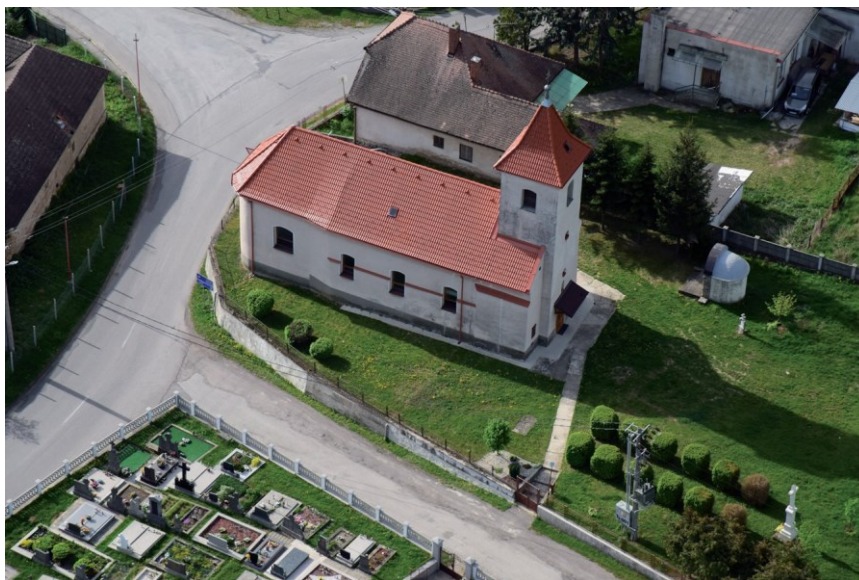
Obnova strechy na Kostole Panny Márie z 18. storočia
